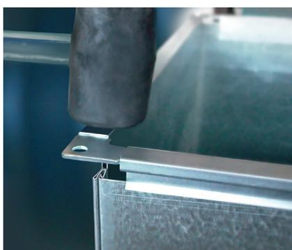
4. Прикрепить фланцы к воздуховодам механически с помощью саморезов, вытяжных заклепок или специального инструмента с шагом 50-75 мм.
